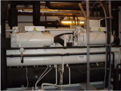
Abbildung 29: Großkältemaschine mit einer Kälteleistung von 531 kW (Foto: Österreichische Energieagentur, 2012)
