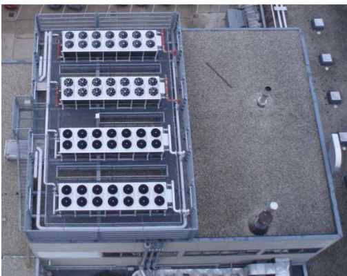
Abbildung 30 Free-Cooling-System des Westverbau (Foto: Österreichische Energieagentur, 2012)
